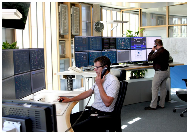
Blick in die Mainova Leitwarte Netzführung Gasnetze
